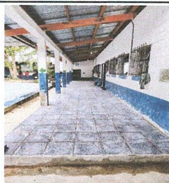
Foto 4: Mejoramiento de piso de corredor frente a aulas de módulo 3
