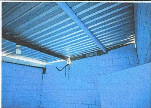
Foto 3: Mejoramiento a cubierta de lámina
