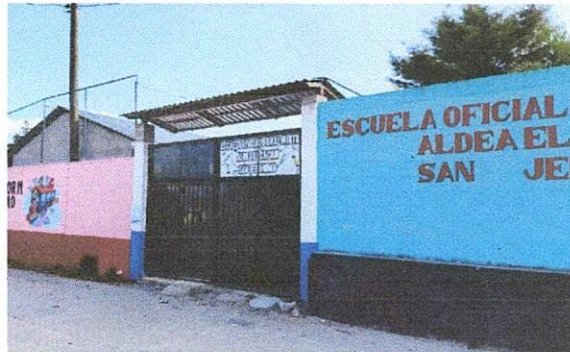
Foto 2: Mejoramiento y Techado del porton
